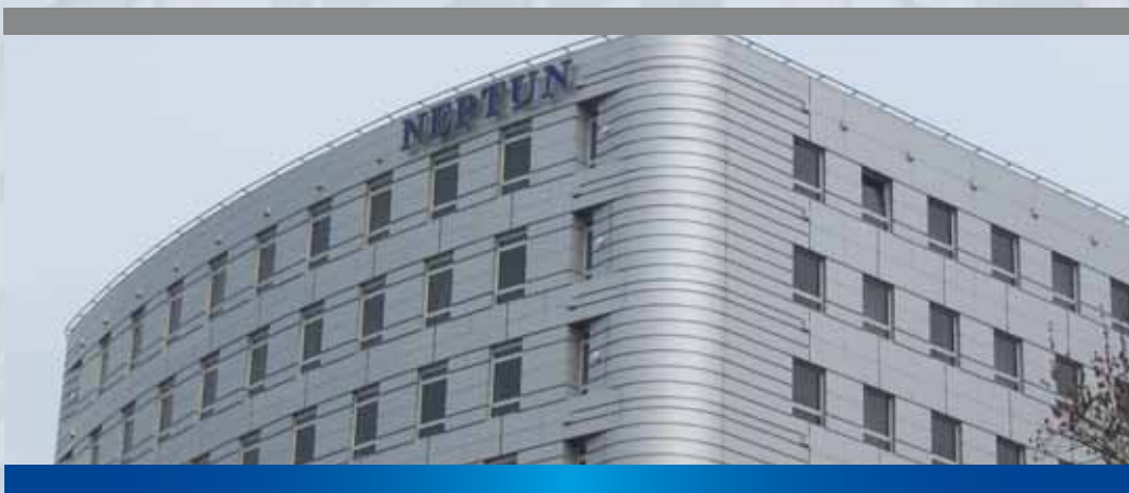
4. EMPARK - budynek Neptun DSO - Dźwiękowy System Ostrzegawczy EVAC - Voice Evacuation System
