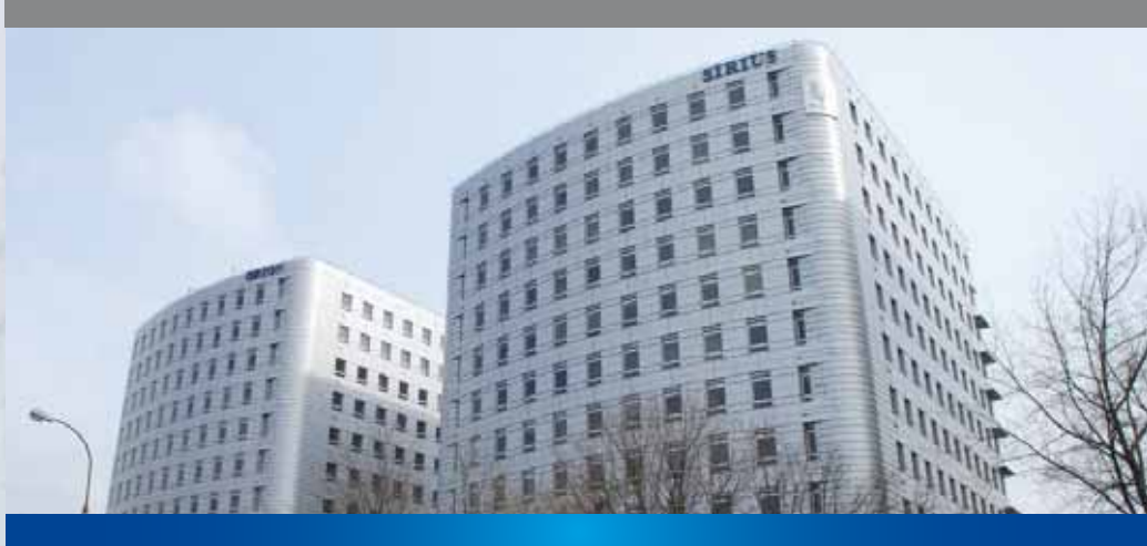
2. EMPARK - budynek Syriusz DSO - Dźwiękowy System Ostrzegawczy EVAC - Voice Evacuation System
